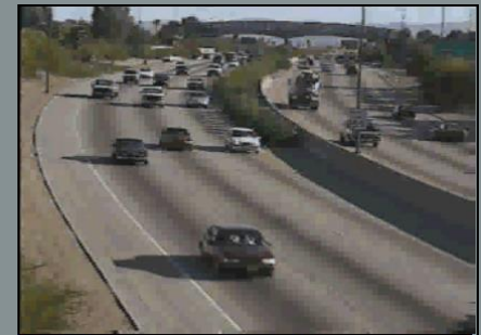
NIVEL C: Rango de flujo estable, tiene restricciones, se siente interacción con usuarios
