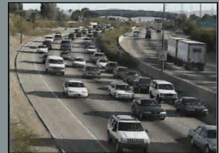
NIVEL F: Circulación forzada y congestionada. Demanda supera capacidad de la vía, colas.
